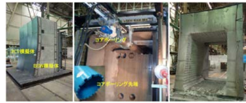
図4 生体遮へい壁撤去要素試験
