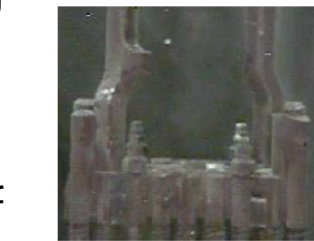
図3 4号機使用済燃料上部タイプレート締結部の外観
